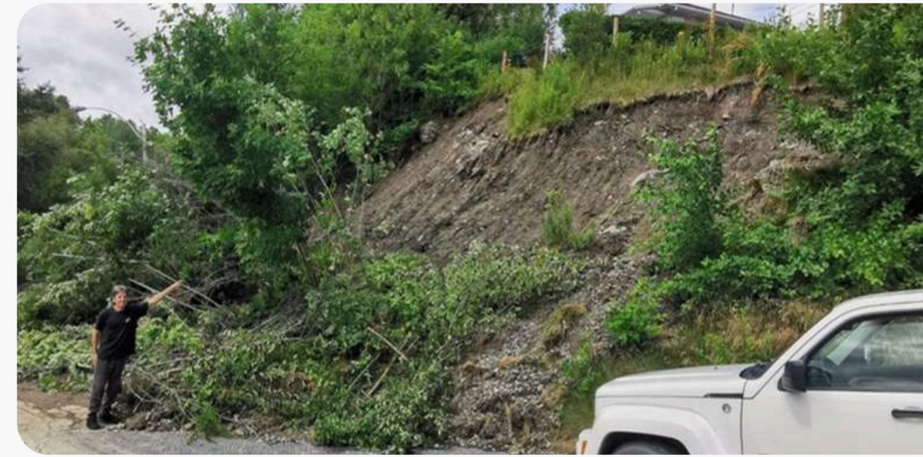
Glissement de terrain à Saint-Georges, (30)
